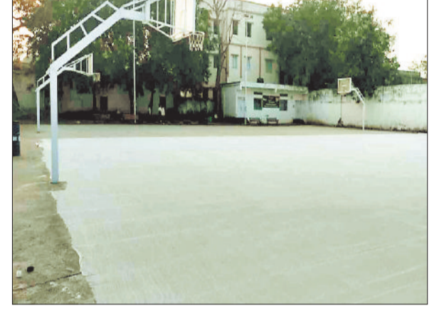
निर्माणाधीन बास्केटबॉल कोर्ट।
